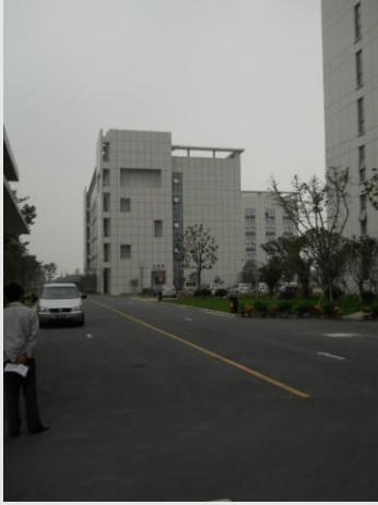
Edificio de dormitorio de los empleados.
